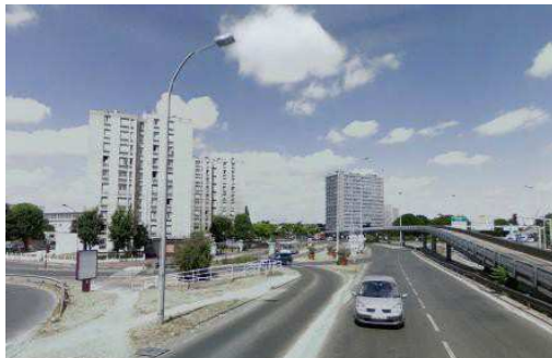
Entrée de ville au niveau du pont de Bezons
