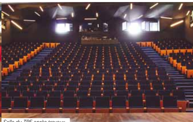
Salle du TPE après travaux.
