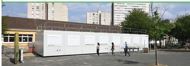
Installés cet été, ces modulaires ont nécessité des travaux de préparation pour les raccordements aux réseaux d'eau, d'électricité et d'assainissement. Et même parfois la création de rampes PMR pour permettre leur accès aux bâtiments existants ou à la cour de récréation, comme ici à l'école PVC, qui accueille un nouveau modulaire.
