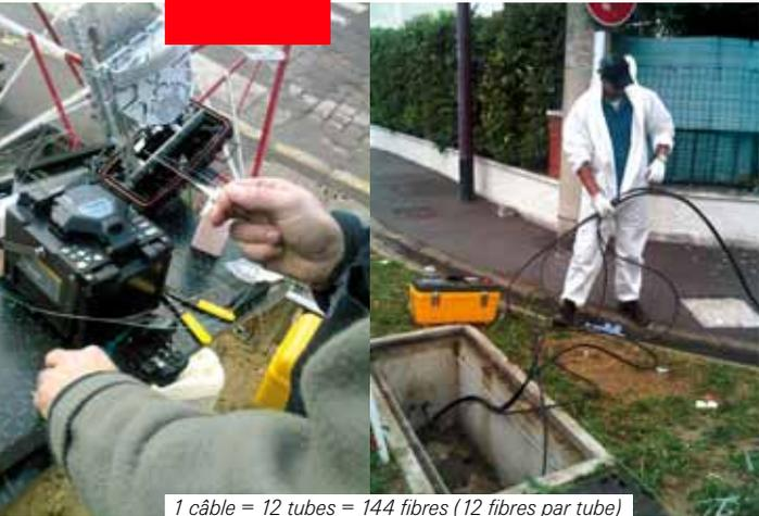
1 câble = 12 tubes = 144 fibres (12 fibres par tube)
